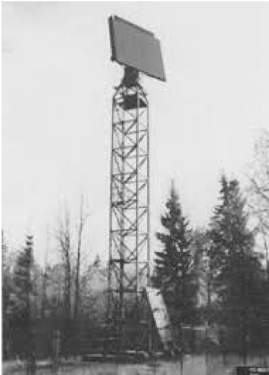
Serieutförande av mast och luckor vid skyddad anläggning
